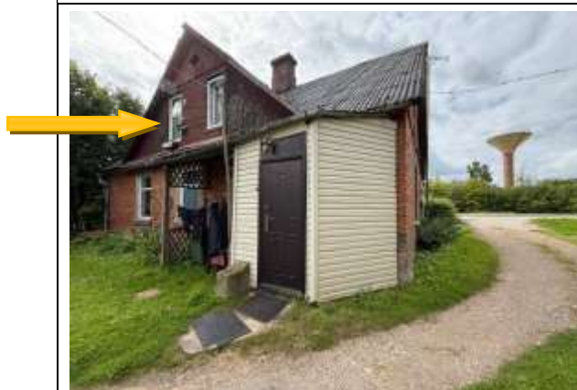
Dzīvokļa Nr.4 logs un izvietojums ēkā
